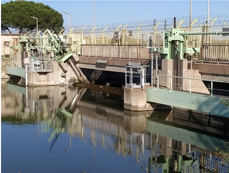
Le barrage en aval de la prise d'eau du GPMM qui régule le débit du canal et empêche la remontée d'eau salée (photo garants)
