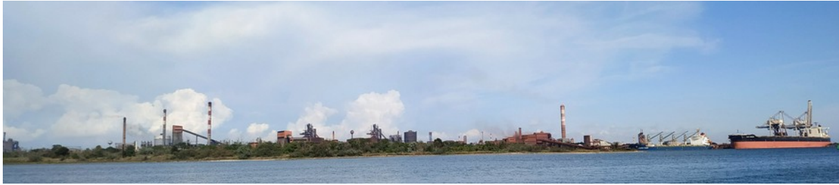
La zone industrialo-portuaire de Fos-sur-Mer vue du site de H2V Marseille Fos (photo garants)
